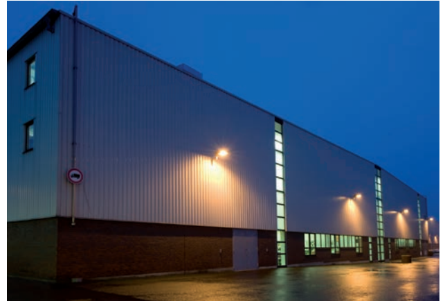
Einsatz energieeffizienter Beleuchtung.
