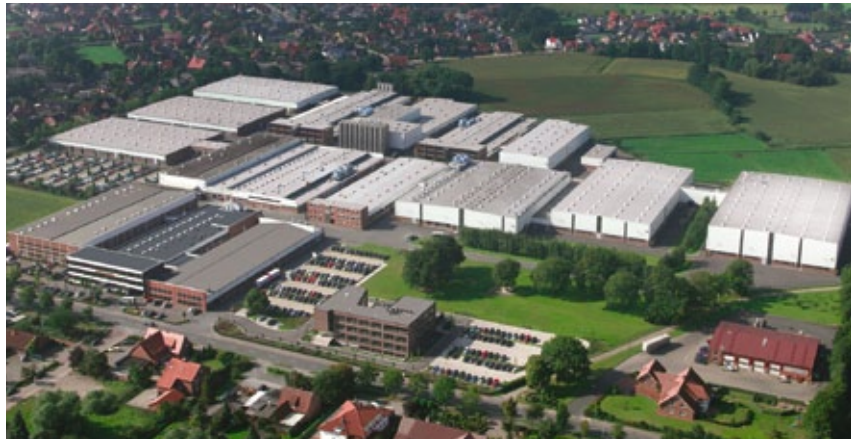
Germany, Plant 1: Pöppelmann GmbH & Co. KG, Kunststoffwerk-Werkzeugbau, Lohne.
