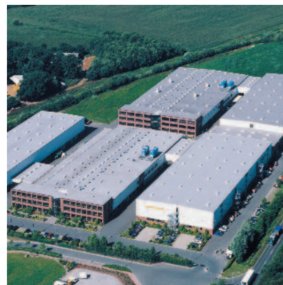
Germany, Plant 2 (K-TECH®): Pöppelmann Kunststoff-Technik GmbH & Co. KG, Lohne.
